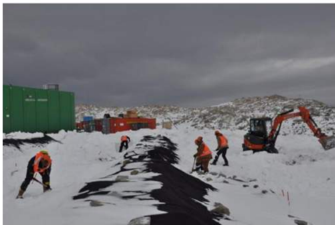
Figura 1.14. Biorremediación mediante uso de biopilas en una base antártica australiana.
