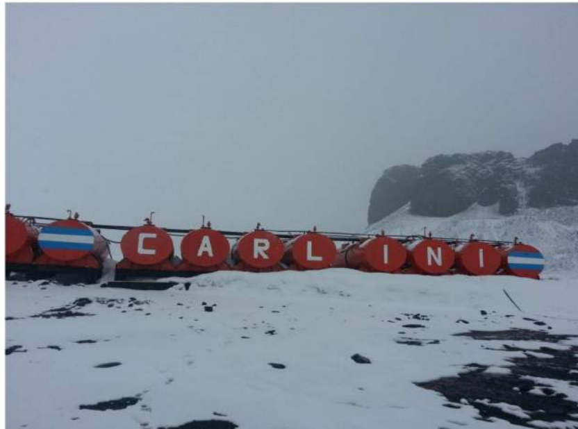
Figura 1.5. Tanques de almacenamiento de gasoil (20.000 l) en la base Carlini, expuestos a rigurosas condiciones meteorológicas.
