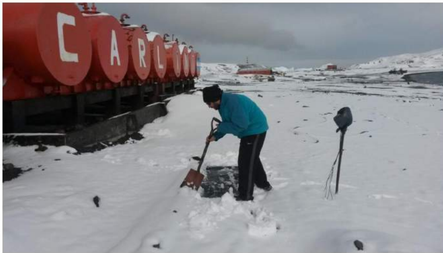
Figura 4.11. El suelo en tratamiento fue protegido de las adversas condiciones climáticas por la utilización de la geomembrana.
