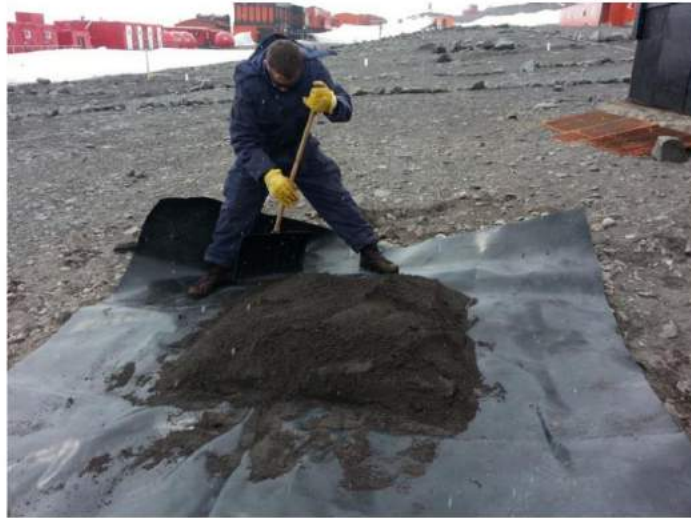
Figura 4.3. Conformación de las biopilas en forma de pirámide truncada y mezclado luego del agregado de nutrientes.
