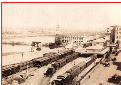
Aduana Taylor y Estación Central de Tren
