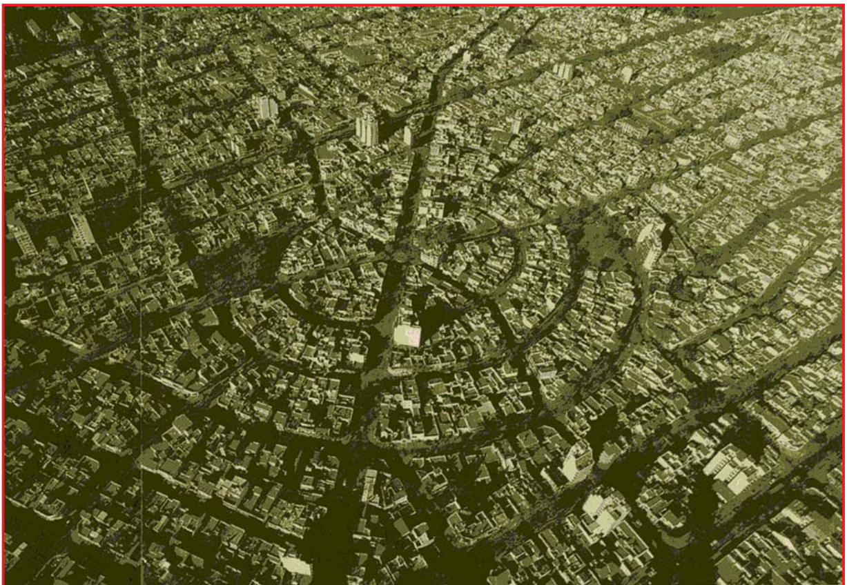
Vista Aérea Parque Chas
